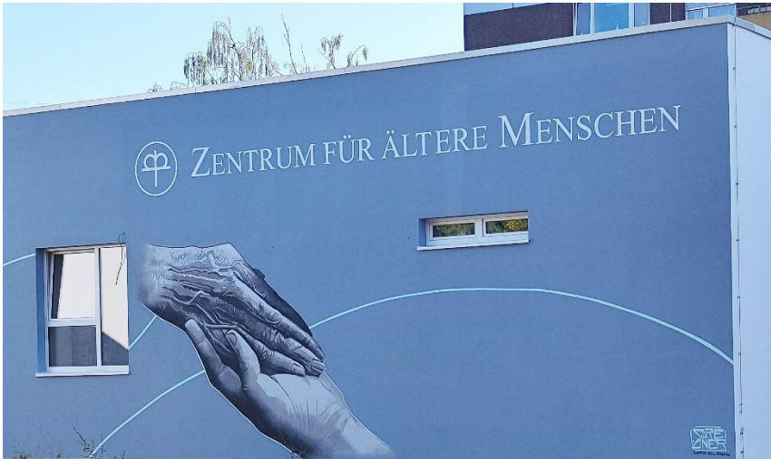
Dennis Mau / Fassade fertig gestellt
